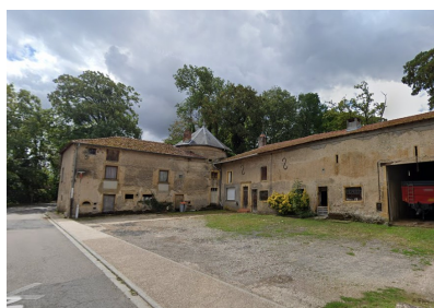
Acquisition de la ferme rue du Château à Montoy
