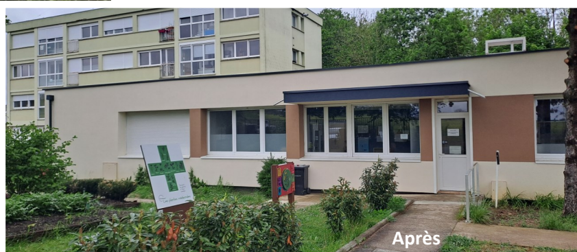
Etanchéité et isolation thermique de la maison médicale
