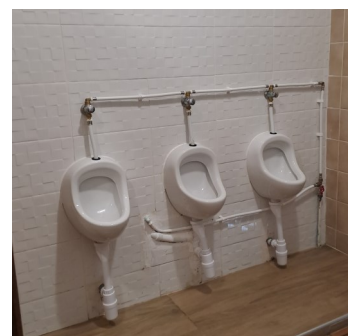
Rénovation des toilettes de l'école primaire
